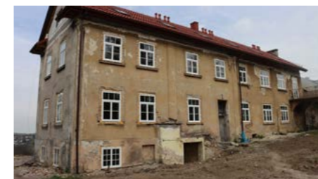
Przeznaczony do remontu budynek Diakonu Zeńskiego „Eben-Ezer” w Dziegielowie
