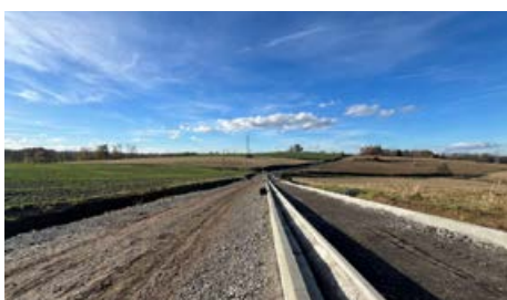
Ulica Wielodroga w Puńcowie w trakcie przebudowy, październik 2025
