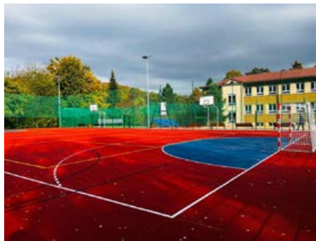
Boisko w Cisownicy po remoncie
