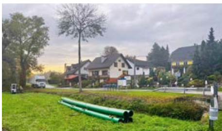
Budowa kanalizacji sanitarnej w Bażanowicach
