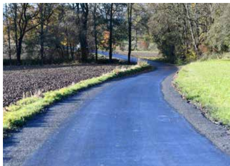
Ulica Dworska w Bażanowicach po remoncie
