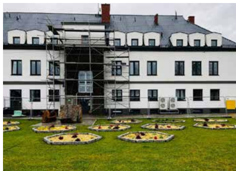
Trwa kompleksowy remont Gminnego Ośrodka Kultury w Goleszowie
