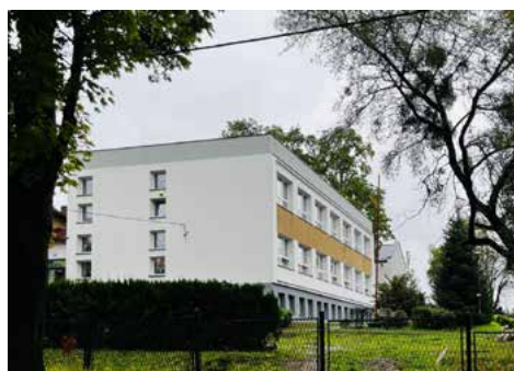
Trwa rozbudowa szkoły i przedszkola w Bażanowicach
