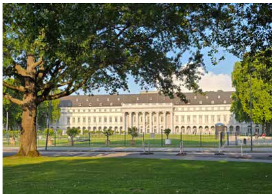
Kobleniec – Pałac Elek- torów
