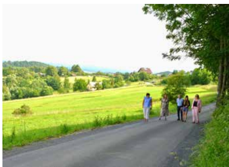
Ulica Na Budzin w Cisownicy po remoncie
