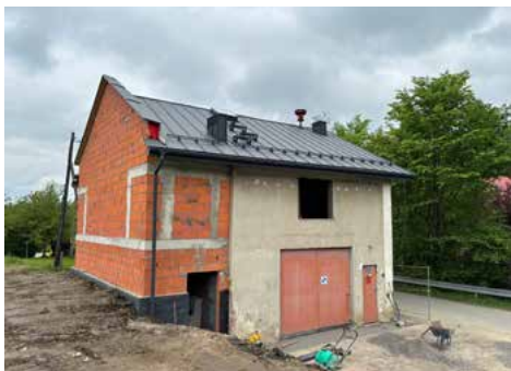
Trwa rozbudowa budynku OSP w Lesznej Górnej
