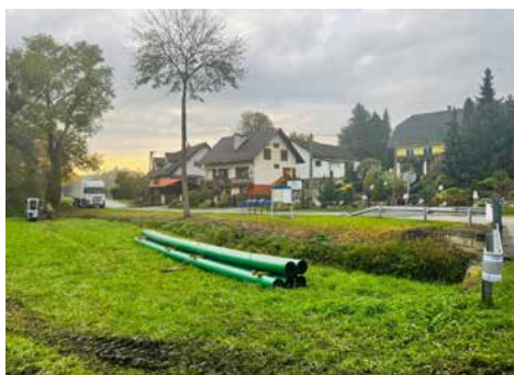
Trwa budowa kanalizacji w gminie Goleszów
