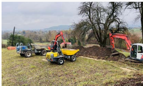
Rozpoczęcie budowy kanalizacji sanitarnej w Bażanowicach
