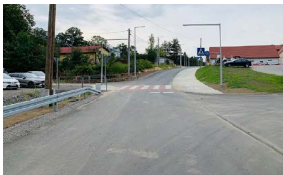
Wyremontowana ul. Kojkowicka w Puńcowie
