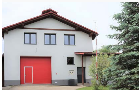
Budynek OSP w Godziszowie po remoncie
