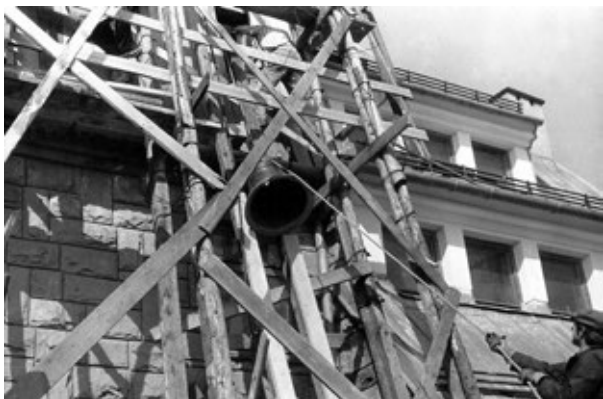
Zawieszenie nowych dzwonów na wieży kościoła ewangelickiego w Cisownicy w 1981 r. Źródło: www.cisownica.luteranie.pl [dostęp: 5.11.2024]
