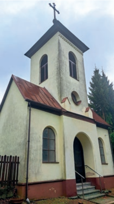
Kaplica cmentarna z dzwonnica, wybudowana w 1910 r. Fot. Mikołaj Haratyk
