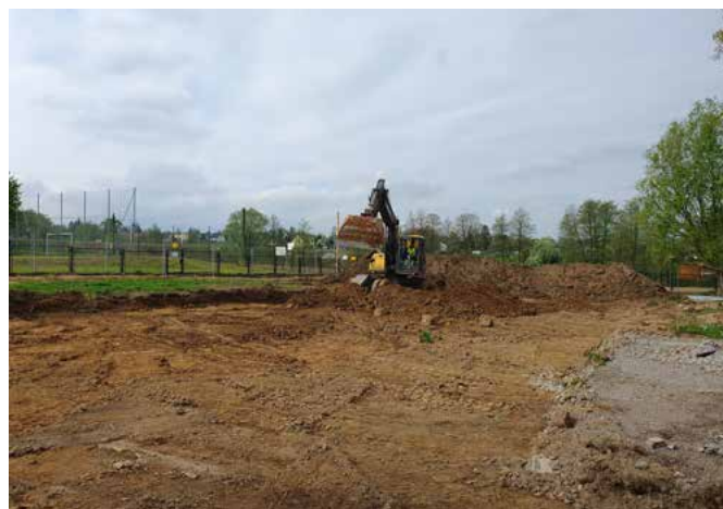
Postępy na placu budowy
