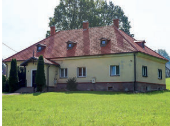
Dzięki dotacji z Gminy, wyremontowano dach katolickiej plebanii w Puńcowie
