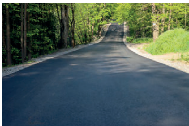
Dzięgielów, ul. Zamkowa
