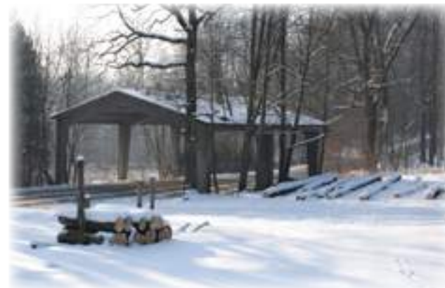
Zadaszenie nad drogą Přístřešek nad cestou
