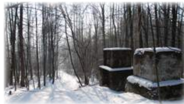
Szlak zimową porą - pozostałości betonových podpór kolejki Trasa v zimě - pozůstatky podpěr lanovky
