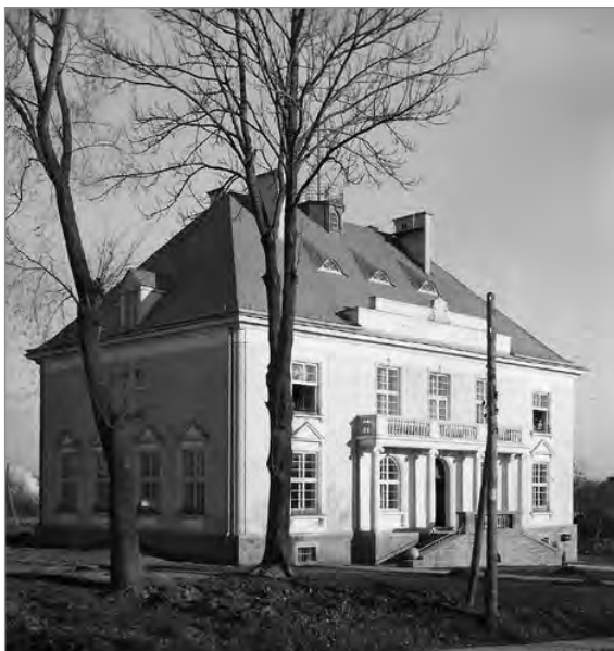
Goleiszów, Urząd Gminny 1930 r. (przód budynku)
