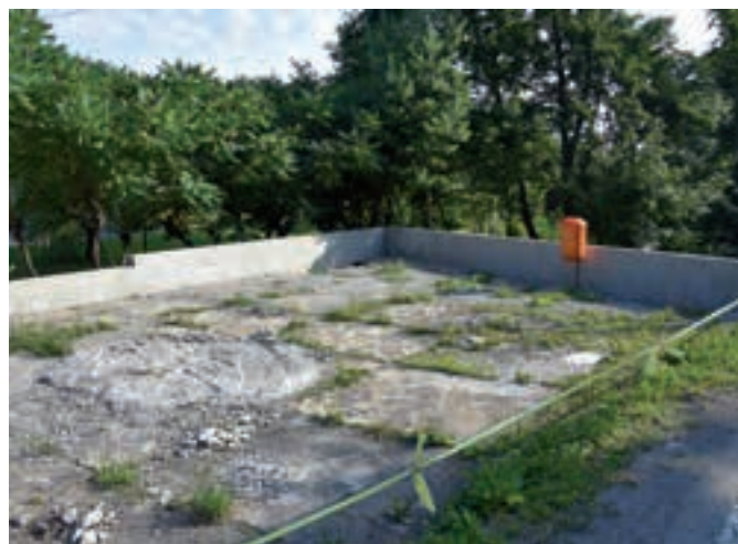
W trakcie remontu
