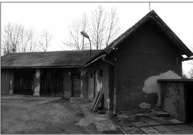
Budynki gospodarcze przed rozbiórką
