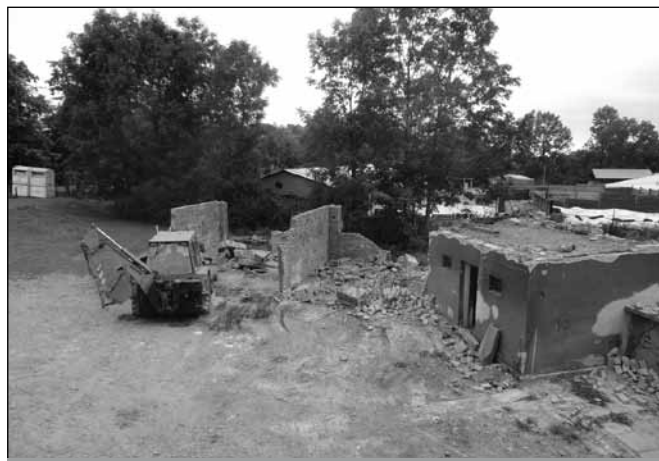
Budynki w trakcie wyburzania
