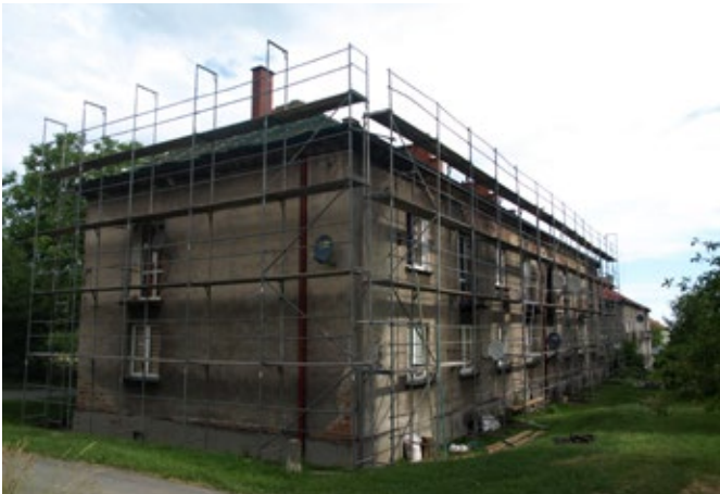
Cisownica, wymiana pokrycia dachowego na bloku
