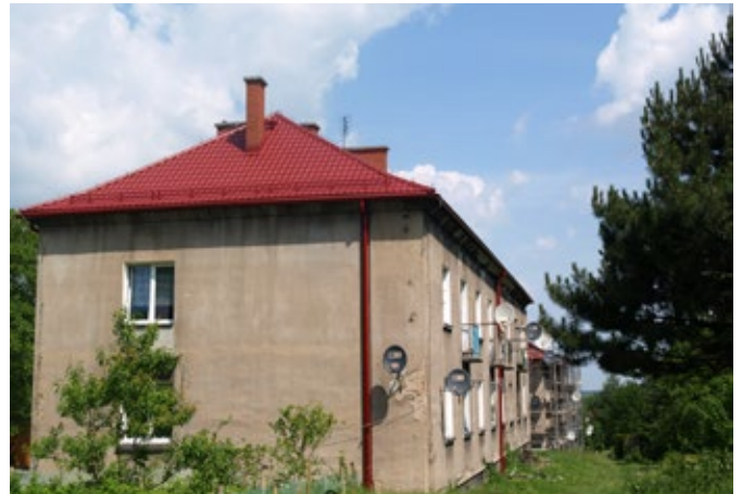
Nowe pokrycie dachowe
