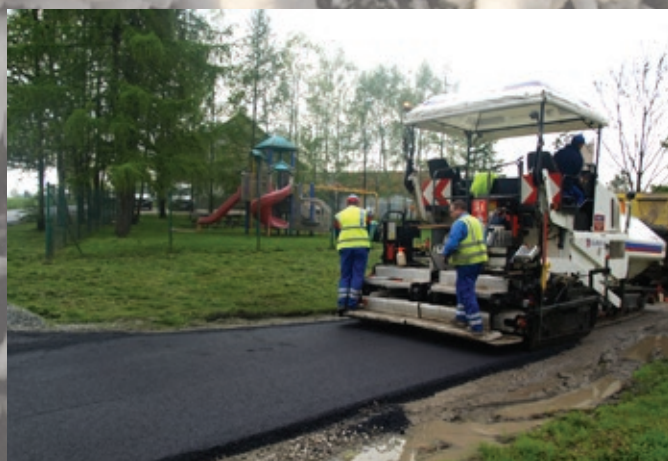
Bazanowice, ul. Spokojna, układanie nowego asfaltu
