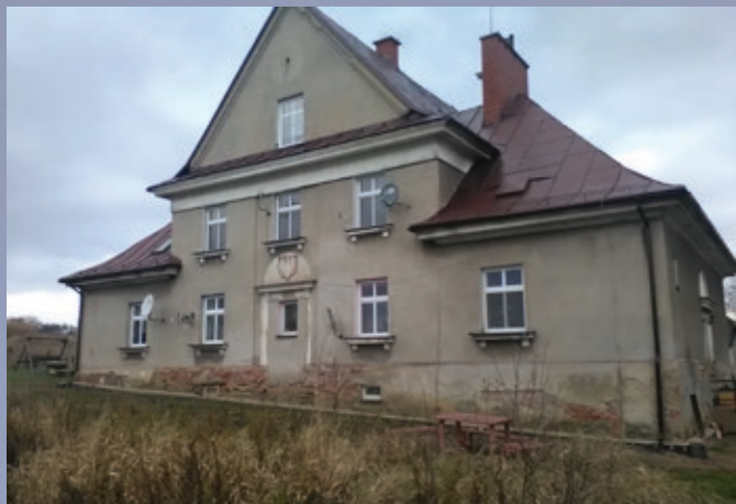
Puńców, ul. Widokowa, budynek przed remontem
