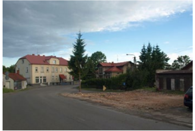
Miejsce po rozebranym budynku
