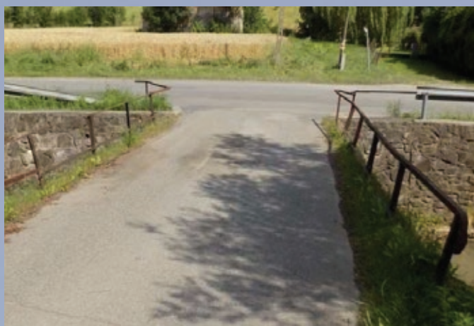
Puńców, most przed remontem
