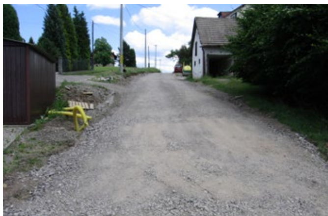
Cisownica, ul. Krokusów w trakcie budowy
