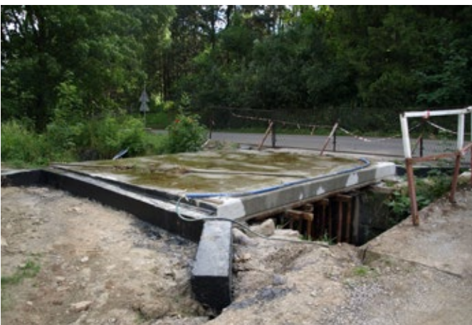
Cisownica, budowa mostu na ul. Zadni Gaj
