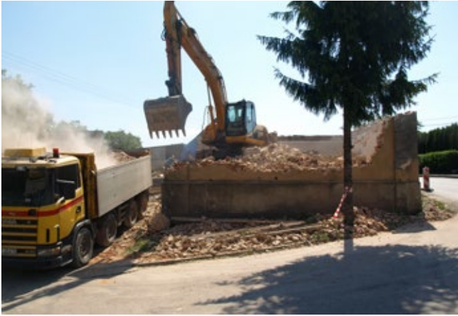
Golezów, rozbiórka budynku w ciągu ul. Ustrońskiej
