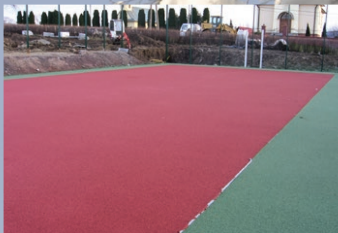
Kisielów, budowa boiska wielofunkcyjnego
