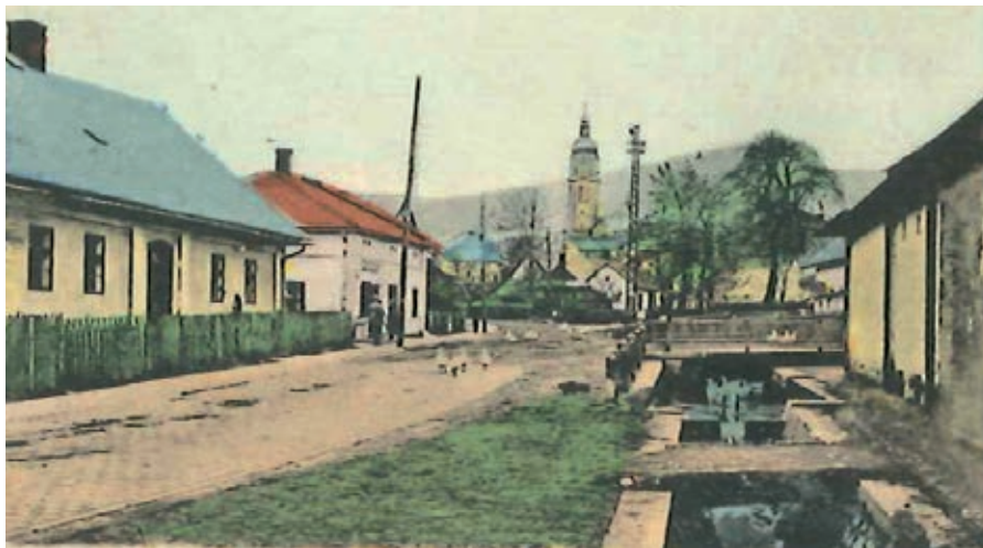
Fragm. pocztówki z 1932 r., dzisiejsza ulica Wolności, z prawej kanał ściekowy
