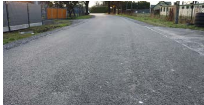
Ul. Radoniowa w Goleiszowie po remoncie
